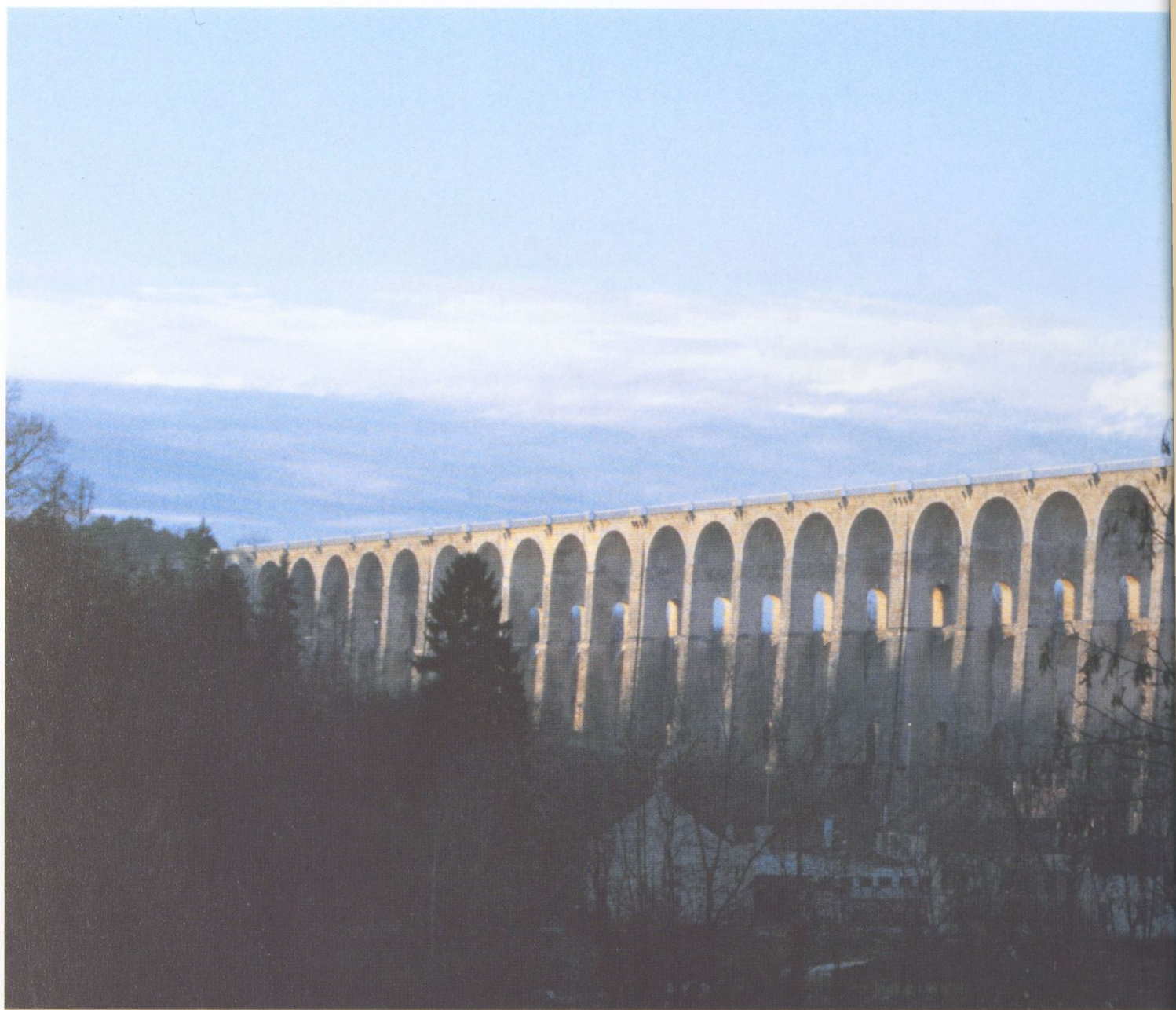
Construit en 1855 et 1856 par quelque 2 500 ouvriers, le viaduc, long de 654 m, compte 50 arches et culmine à 150 m du sol
