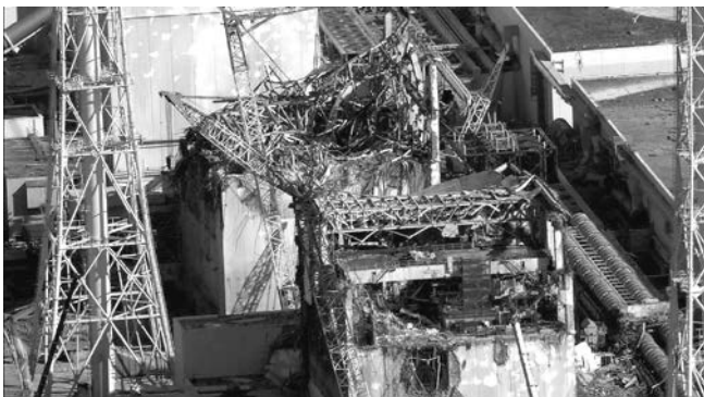
Centrale de Fukushima avant et après le 11 mars 2011 © Kami Productions
