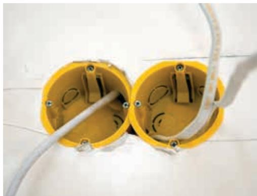
↑ Lors du test d'infiltrométrie, une fuite apparaît généralement entre la plaque de plâtre et la boîte d'encastrement.
