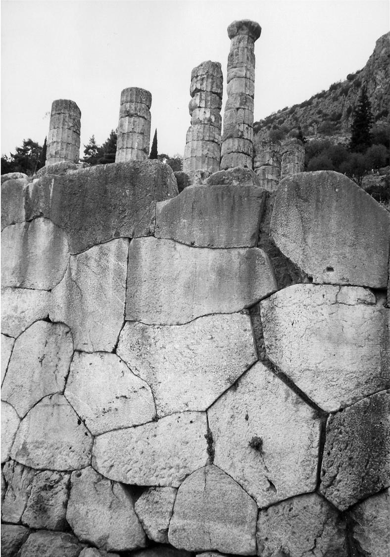
1. Mur d'enceinte et colonnes du Temple d'Apollon à Delphes. Les colonnes ont pivoté sur elles-mêmes, et la large fissure du mur, réparée avec des briques, a peut-être elle aussi une origine sismique.
