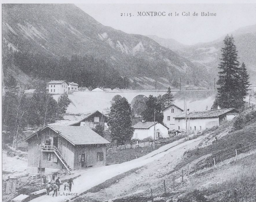
Deux étapes de la construction de la voie ferrée dans le vallon de Montroc : ci-dessus les terrassements de la plate-forme à flanc de montagne avec, au fond, une passerelle en bois à l'emplacement du viaduc ; ci-dessous le viaduc achevé, avec ses talus et les maisons cantonnières de la gare de Montroc-Le Planet. Collection Jean-Pierre GIDE
