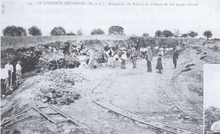
*L'entreprise Beauvéjour, pour construire la ligne de Candé, extrayait la pierre dans des carrières ouvertes localement, dans le sol granitique du Candéen. Des voies Decauville permettaient le transport des matériaux vers le chantier de voie.*
