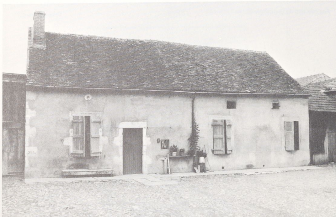
Façade principale de l'habitation, état en 1980.
