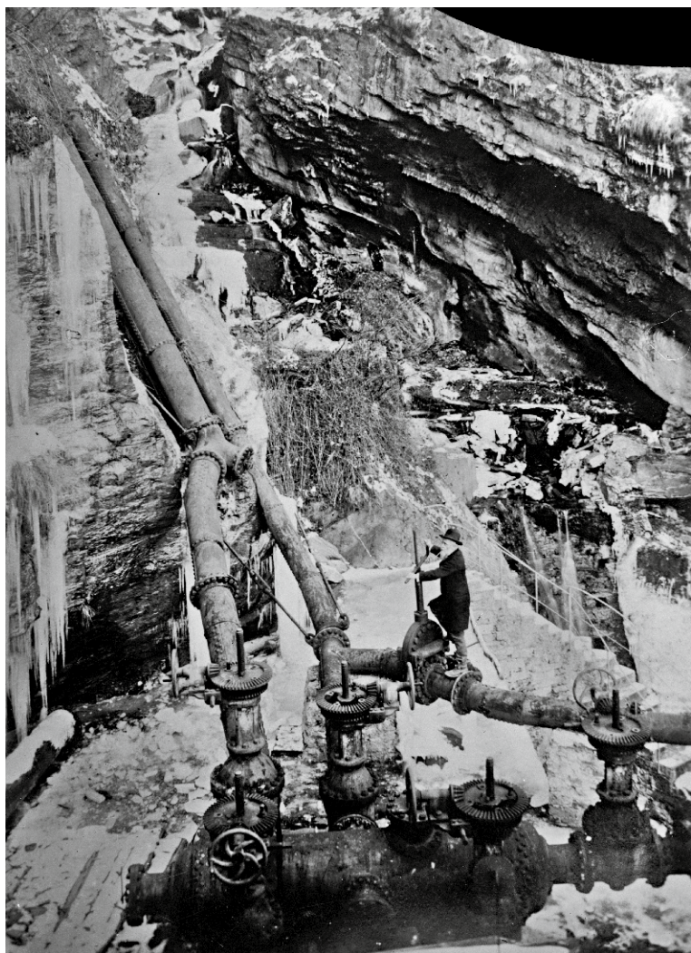
1. Le collecteur des conduites forcées, 1898.
