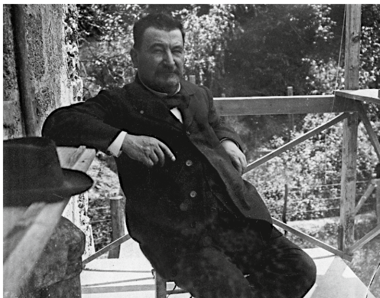
3. Aristide Bergès lors de la construction du bâtiment de la papeterie.
