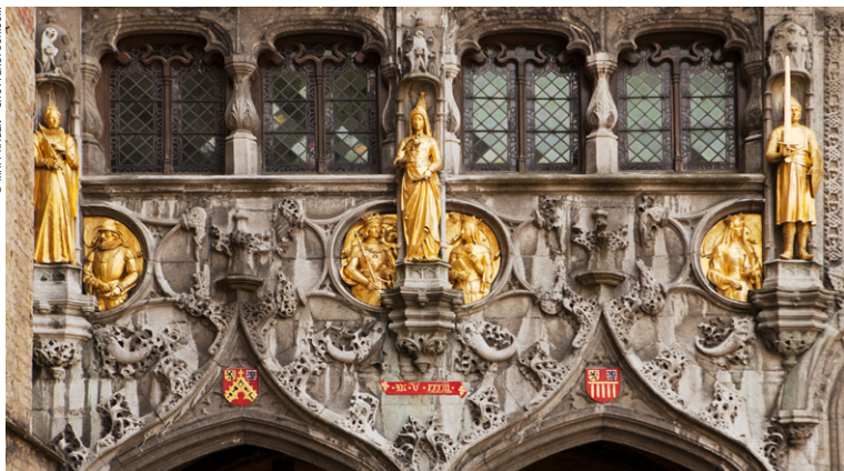
Détail de la façade de la basilique du Saint-Sang.
